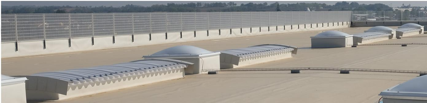
Le coperture **DECK** sono prodotte in continuo con un supporto metallico in acciaio zincato e un supporto all'impermeabilizzazione in cartongesso bitumato, sul quale potranno essere applicate guaine impermeabilizzanti e strati per la protezione della copertura.
